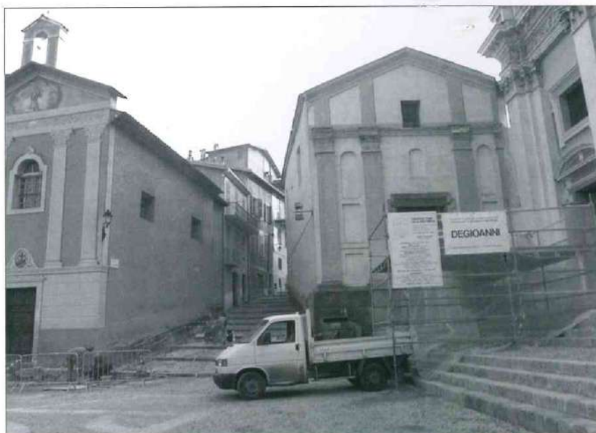
Le chantier de l'ancienne chapelle des Pénitents Rouges à Sospel. Photo Entreprise DEGIOANNI
