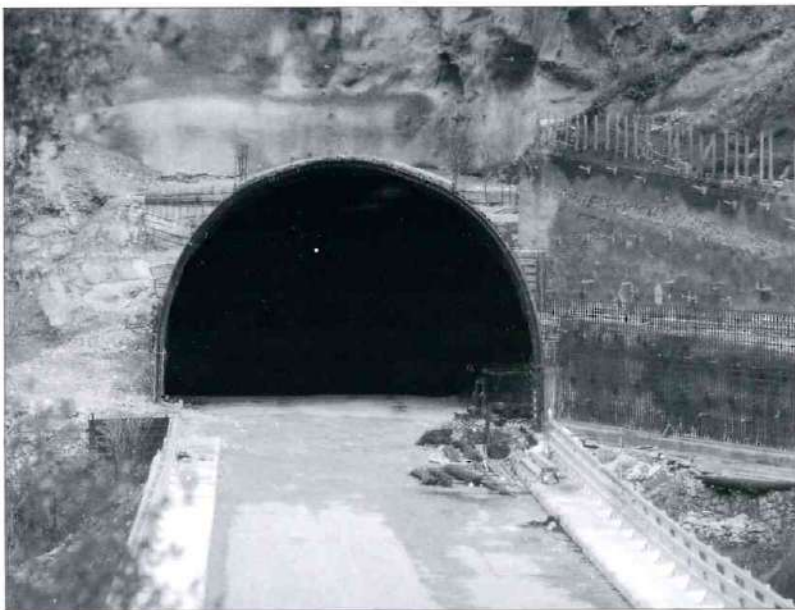
La tête aval du nouveau tunnel des gorges de Saorge. Etat en juin 2000. Photo Michel BRAUN
