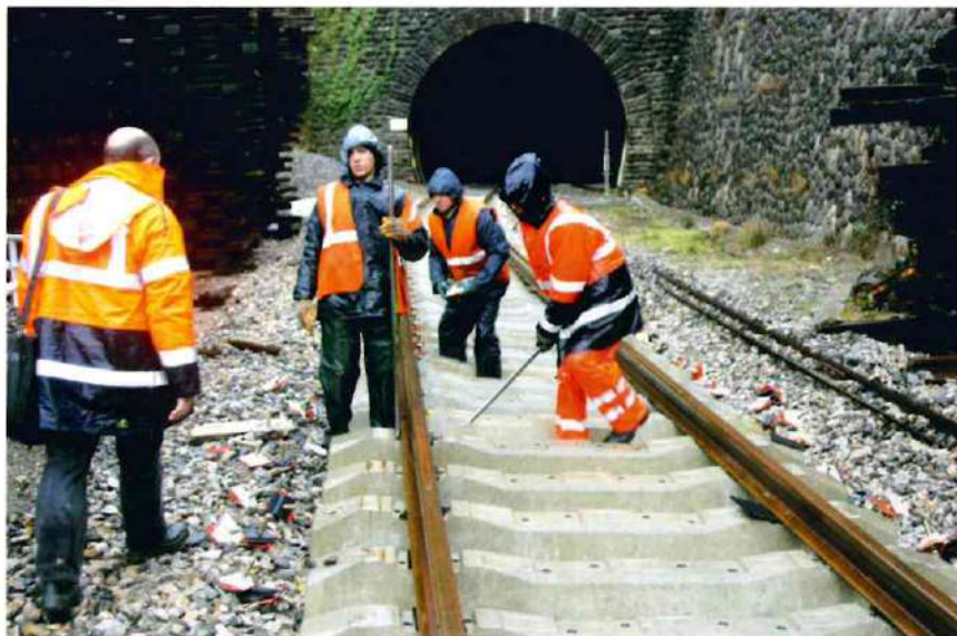
Deux étapes de la pose de la nouvelle voie ferrée entre Sospel et Breil : une machine rapproche les rails sur les traverses, qui sont ensuite réglés à leur emplacement final avant d'être tirefonnés. Photos Georges POMAREDE
