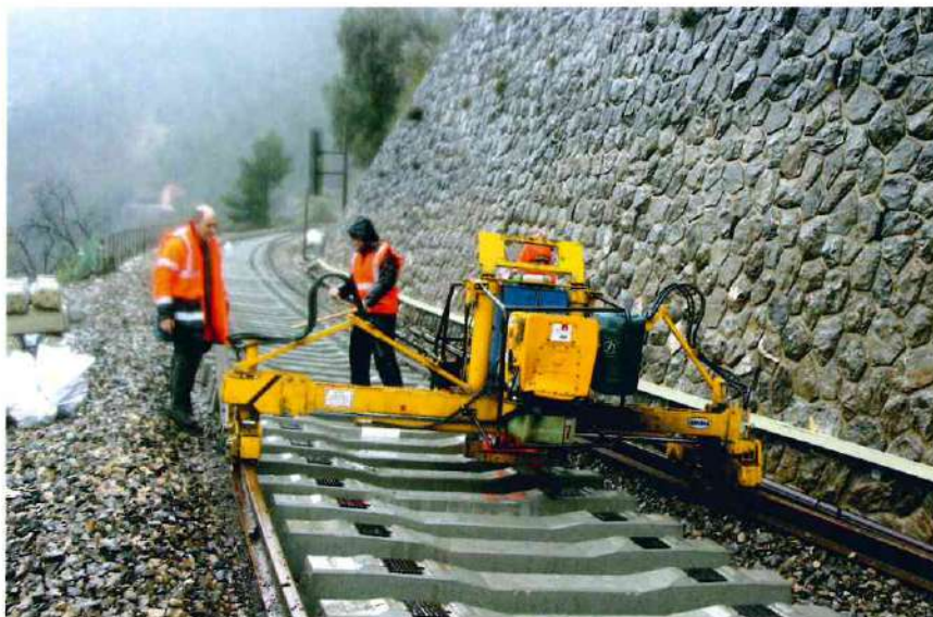
Deux étapes de la pose de la nouvelle voie ferrée entre Sospel et Breil : une machine rapproche les rails sur les traverses, qui sont ensuite réglés à leur emplacement final avant d'être tirefonnés. Photos Georges POMAREDE
