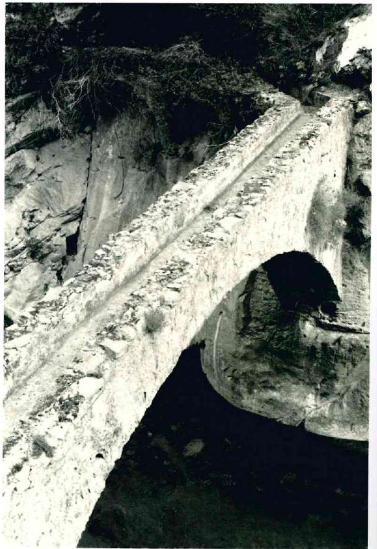
L'ouvrage en maçonnerie, dans son état actuel. Photo Jean Marcel CORDIER
